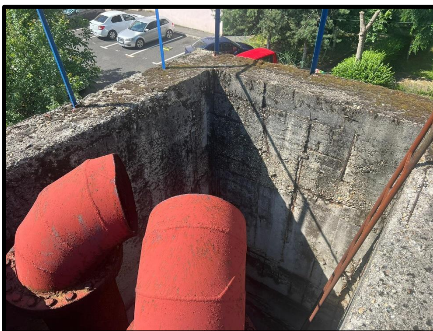
Foto 04. Situatia existenta in zona studziata
