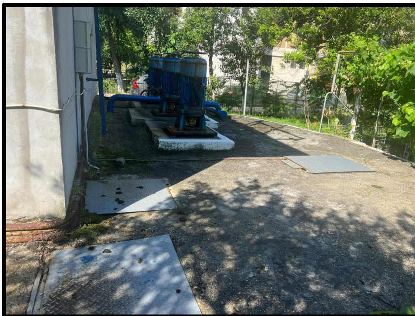
Foto 03. Situatia existenta in zona studziata
