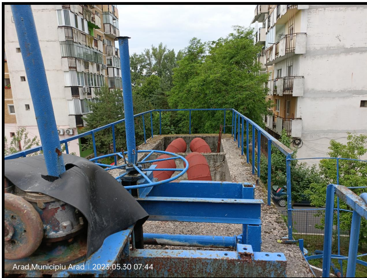
Foto 5 – Lipsa grătarelor la partea superioară a camerei stăvilarelor
